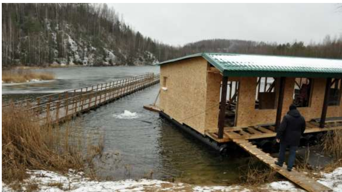
Рис. 5. Строительство плавучего помещения для зимней передержки пеликанов на водоеме Зоопитомника
