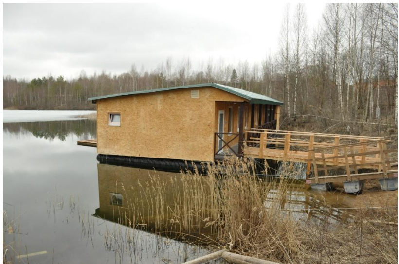
Рис. 7. Зимовальное помещение для пеликанов на завершающей стадии строительства. Зоопитомник МЗ
