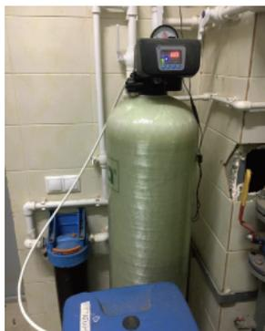
Рис. 2. Фильтры и емкость для отстаивания воды на 3 тонны.
